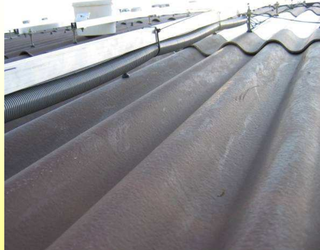
Bündelung und Verlegung der DC-Leitungen auf dem Dach
